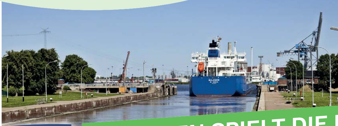
Fotos: Christian O. Bruch/N-Ports
